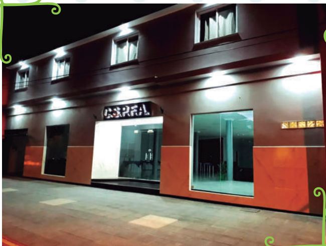
FRENTE DEL EDIFICIO
